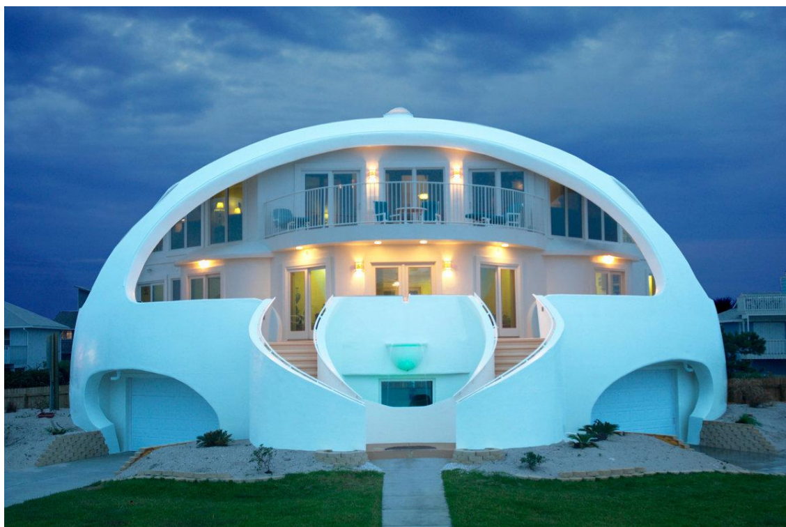
Rys. 1.1.3 Monolityczna kopuła przeznaczona do celów mieszkaniowych, plaża Pensacola na Florydzie [www09]
